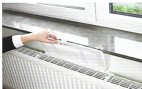
Att byta filter är enkelt eftersom filtret är böjbart
